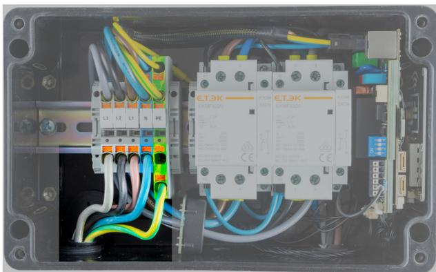
Als Letztes muss die Kabelverschraubung festgezogen werden. Die Verschraubung hat einen Klemmbereich von 11 mm bis 22 mm und soll laut Hersteller mit 10 Nm angezogen werden.
